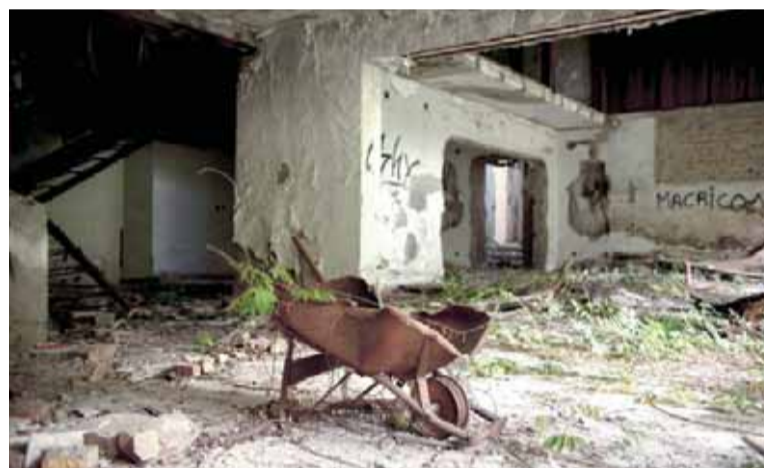
Caserta. Macrico, una delle strutture abbandonate
