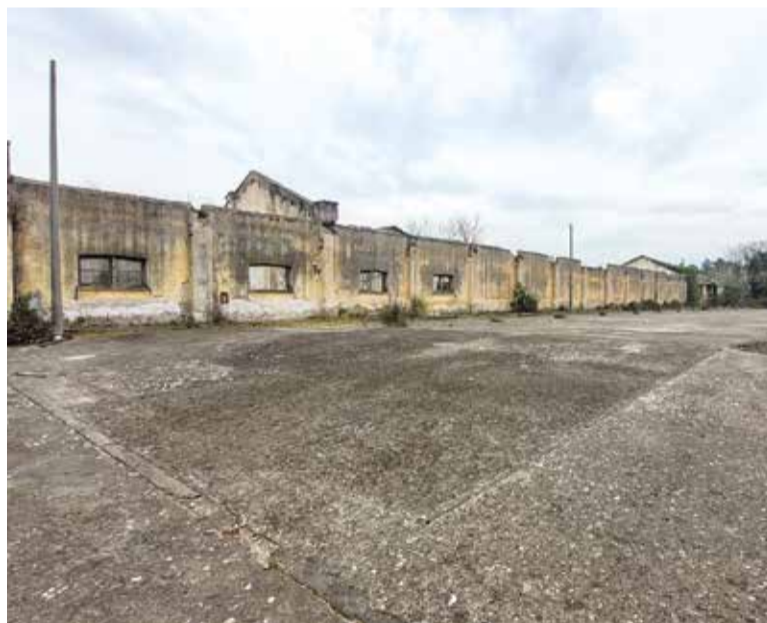
Macrico: uno dei piazzali in cemento armato realizzati dall'Esercito.
